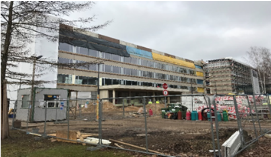
Būvdarbi, Ķīpsalas ielā 6A, Rīgā
