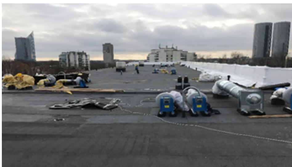
Būvdarbi, Ķīpsalas ielā 6A, Rīgā.
